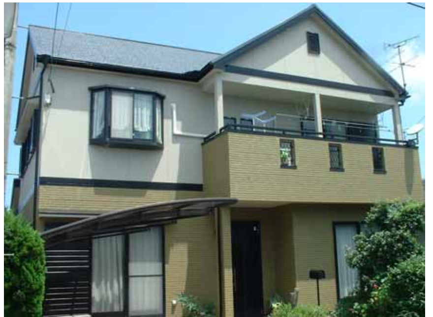
外壁・屋根コーティング
