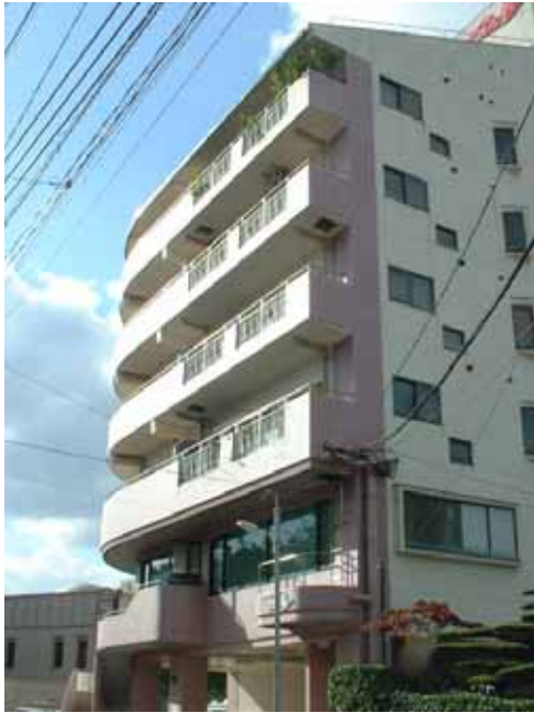
外壁コーティング
