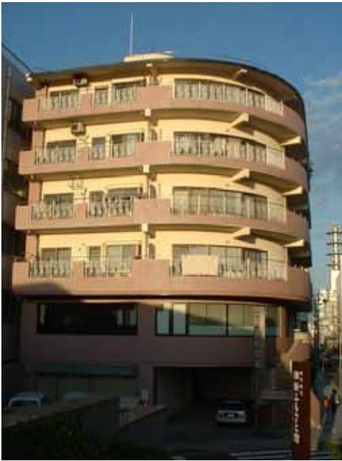
外壁コーティング
