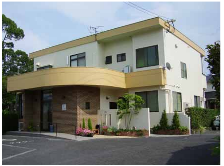
外壁コーティング
