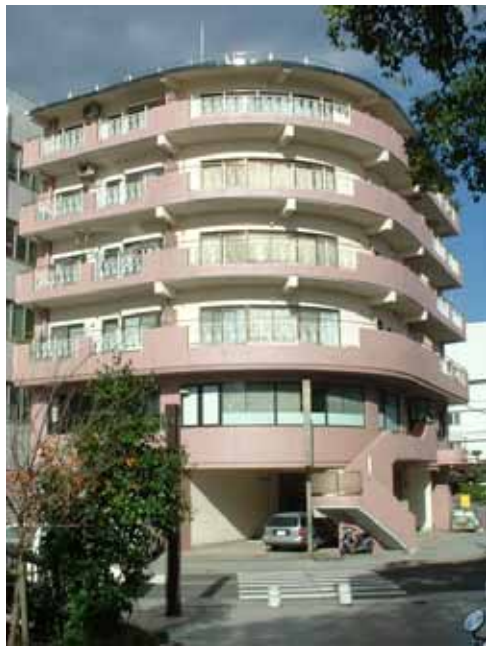
外壁コーティング
