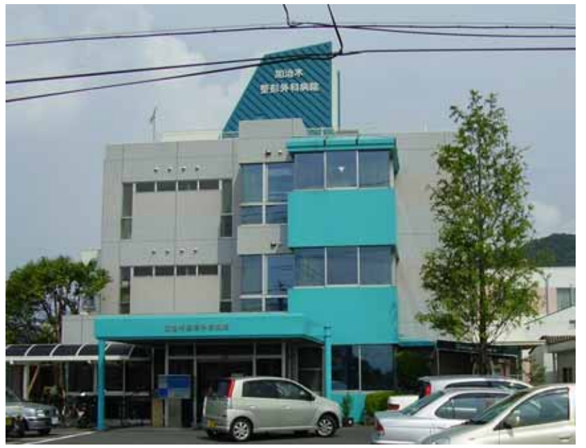
外壁コーティング
